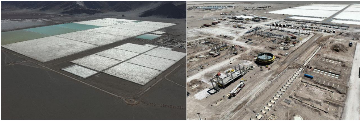
图23: 前两组盐田蒸发池已建成, 厂房建设进行中
