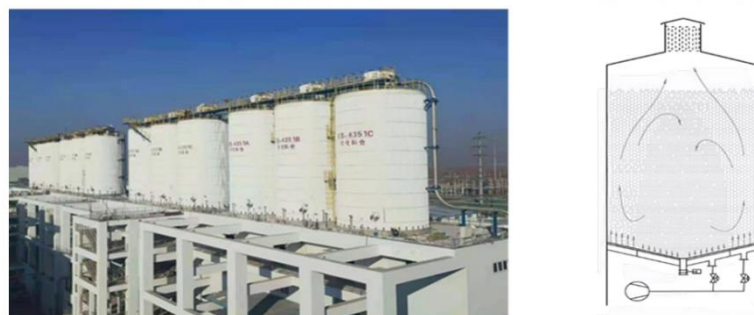
图24：粉料均化系统实景图及原理示意图
