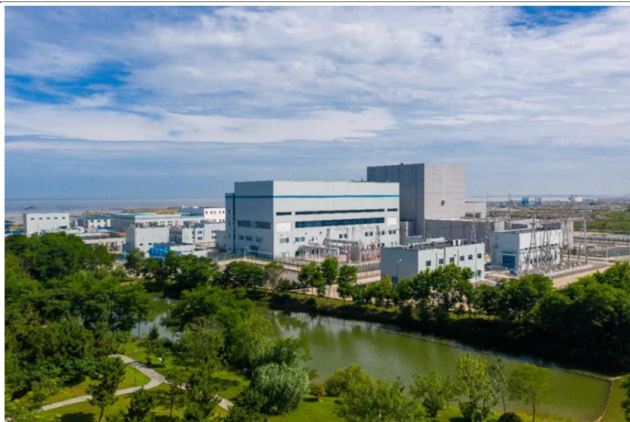
图22. 山东荣成石岛湾高温气冷堆核电站
