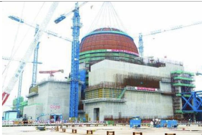
图42. 完成穹顶吊装的福清核电 5 号机组
