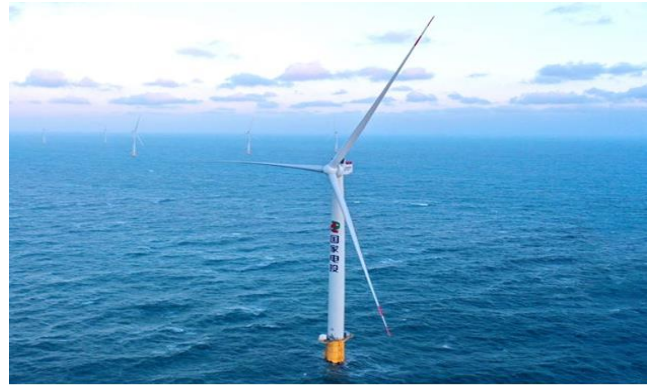
图 15：国家电投全球商用最大单机容量海上风电—— 神泉二海上风电项目
