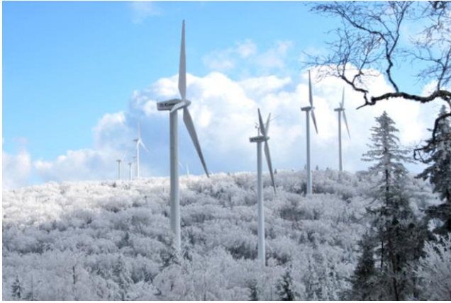
图 11：龙源电力黑龙江小城山风电场
