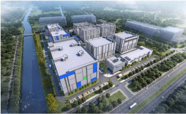
图 29：公司世纪互联新建太仓国际车联网大数据产业园二期项目案例
