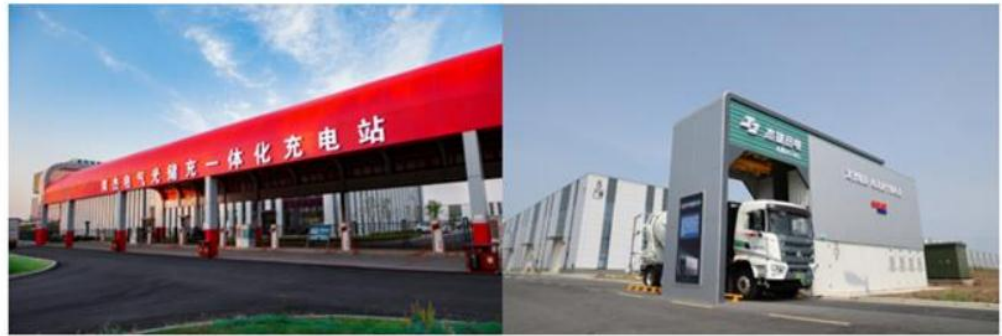
图 33：合肥光储充（换）一体化示范项目
