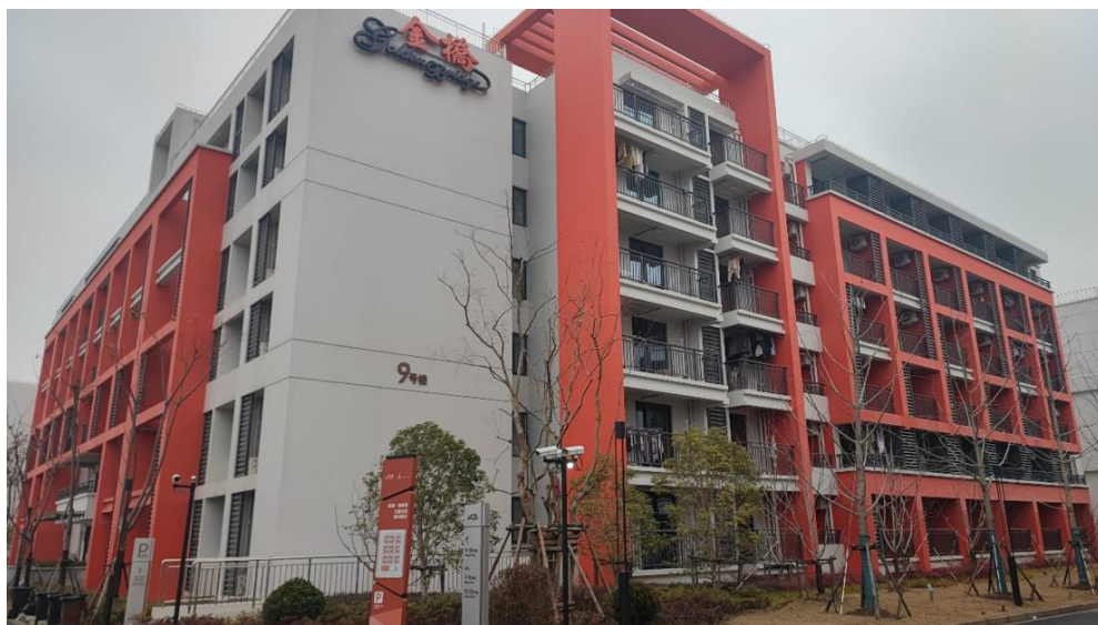
图43：金桥暮紫里建设了“新时代城市建设者管理者之家”
