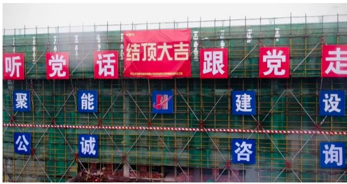
图2：“运动摩托车智能制造项目”工地主楼
