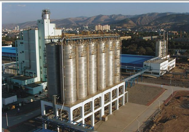
图 5：中国石油兰州石化分公司 30 万吨/年 FDPE 装置
