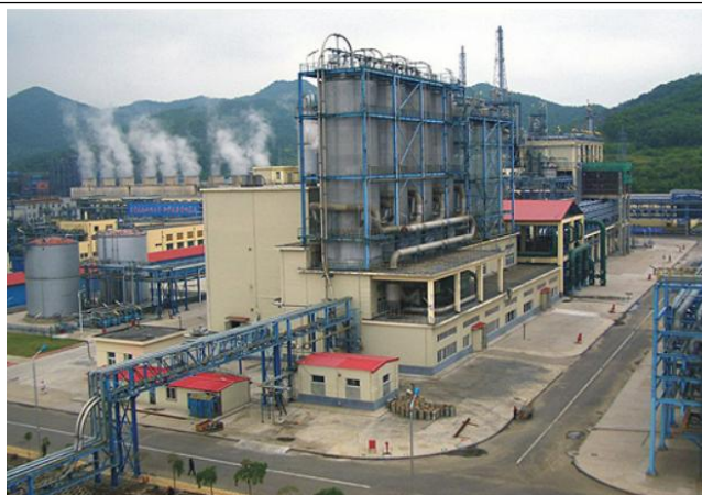
图 6：中国石油吉林石化分公司 HDPE 装置
