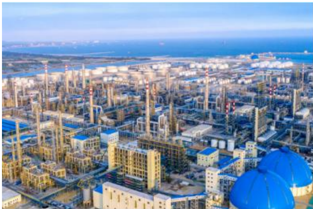
图 18：中国石油广东石化炼化一体化项目
