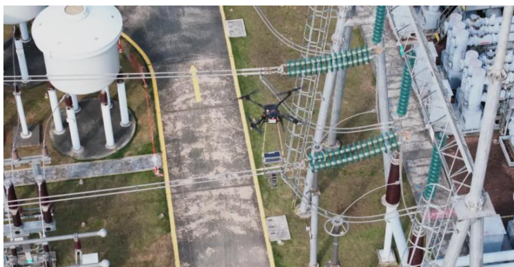
图35：公司“无人机+X光检测设备”检测高跨软导线耐张线夹作业现场
