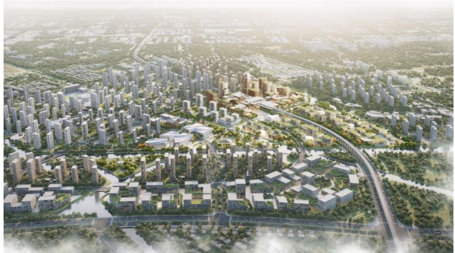
图49：上海青浦凤溪村项目主打 TOD 生活场景重构
