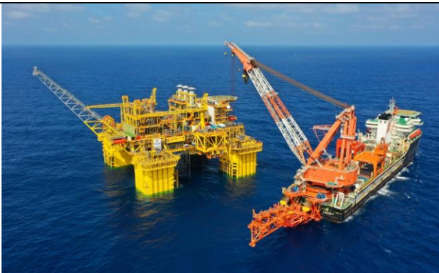
图20:“深海一号”大气田开发工程项目
