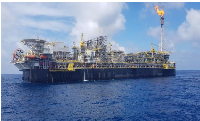
图3:巴西 FPSO 项目
