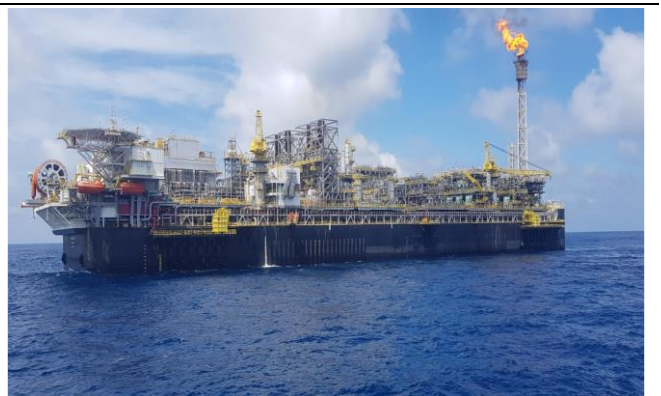
图21:巴西 FPSO 项目
