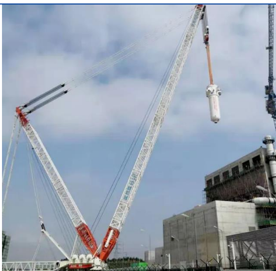
图表 28：2019M7 第二台蒸汽发生器顺利吊装就位
