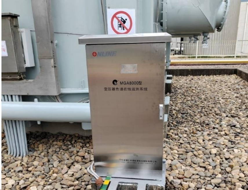
图15.MGA8000 型新一代变压器色谱在线监测系统图
