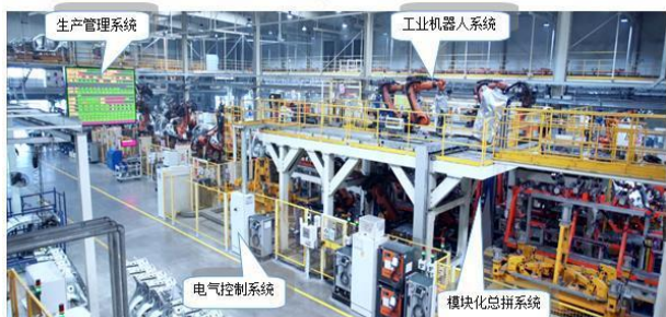
图 5：焊装自动化生产线整线实物图
