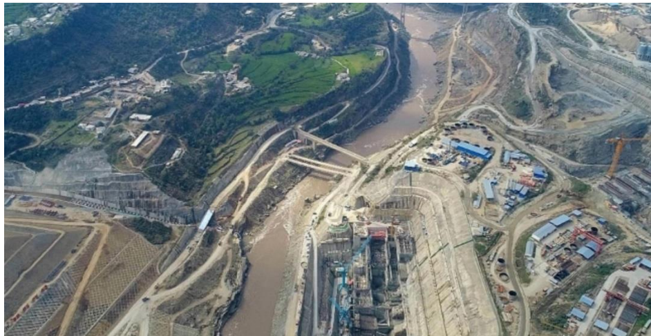
图：巴基斯坦NJ水电站
