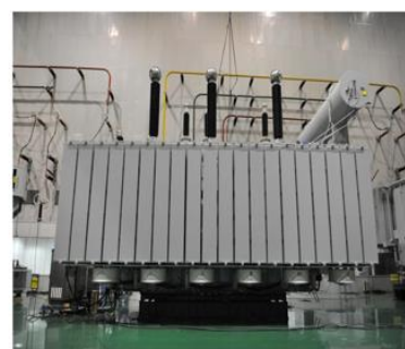
SSZ-240000/220三相三绕组变压器
