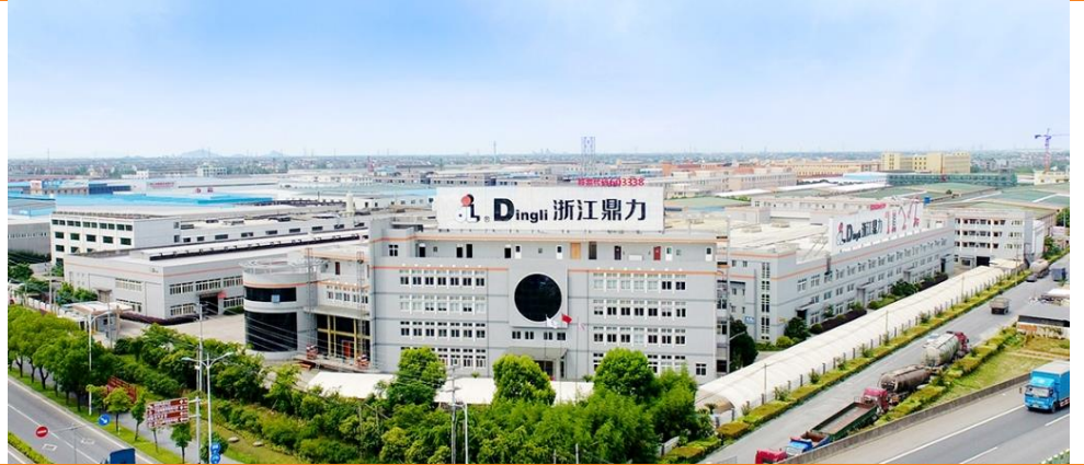
图 1：公司总部大楼
