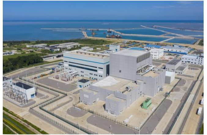
图16: 华能石岛湾高温气冷堆核电站
