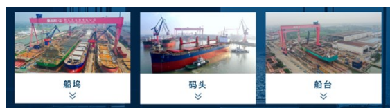
图23：船舶建造基地设施
