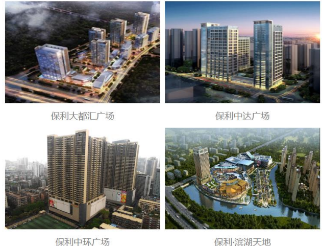
图28：公司服务了较多高端商业综合体项目
