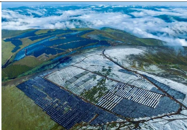
图表 42: 雅砻江两河口水电站水光互补一期项目——柯拉光伏电站
