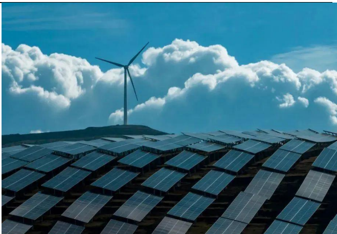
图表 39：云南省巧家县小羊窝光伏电站（隶属于金沙江下游风光水储基地，装机 50MW，2022 年 9 月并网）
