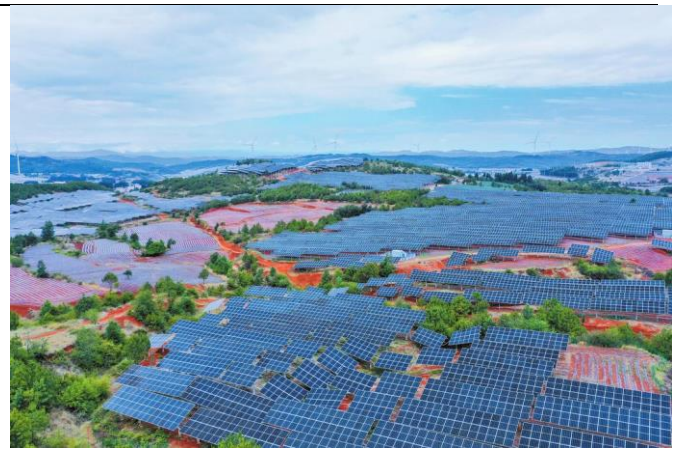
图表 40：曲靖菱角农业光伏发电项目（隶属于澜沧江水风光清洁能源基地，装机 100mw，23 年 4 月并网）
