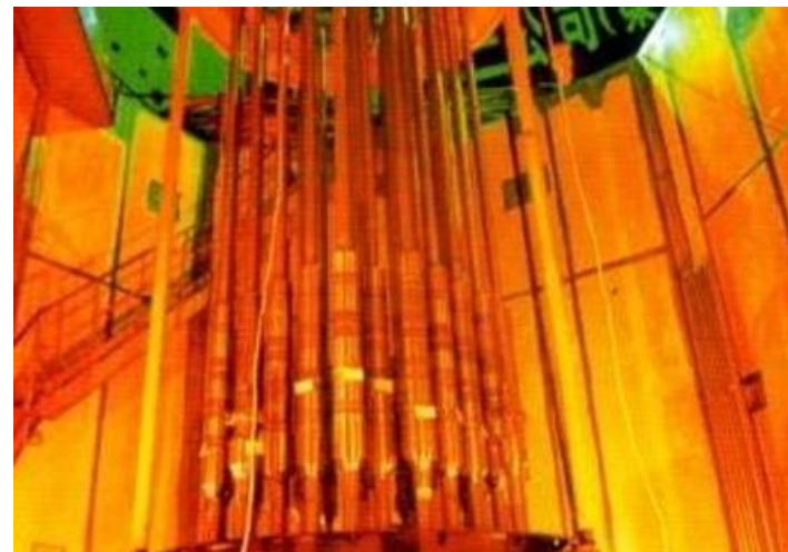
控制棒驱动机构示意图
