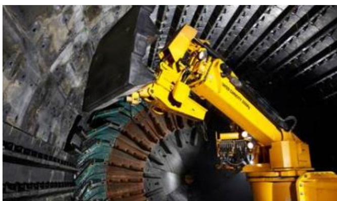
图表 6：某磨机更换衬板现场
