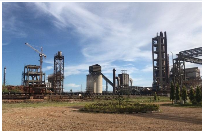
图23：2020 年华新水泥坦桑尼亚石灰石项目点火
