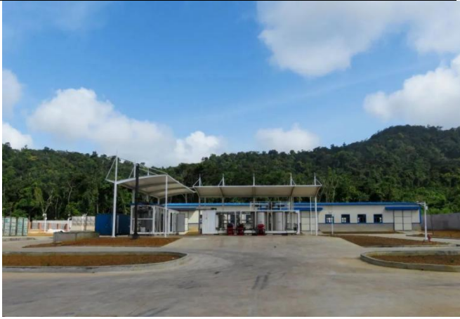
图表 69：利比里亚现场混装炸药半成品制备站
