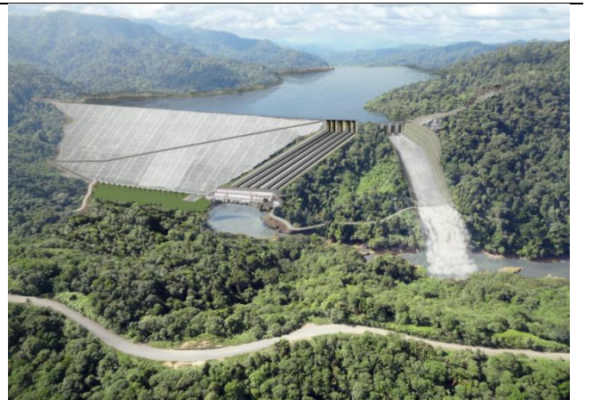
图表 72：马来西亚 BALEH 水电站项目
