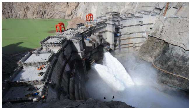
图表 5：公司水利爆破项目案例：拉西瓦水电站项目
