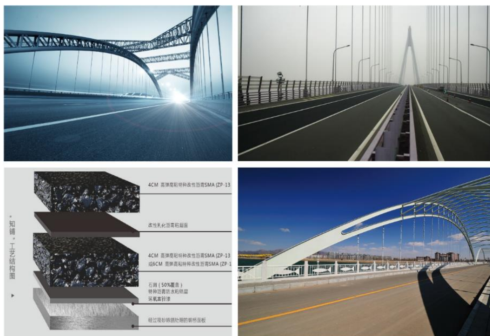
图4：“知铺”钢桥面特种施工
