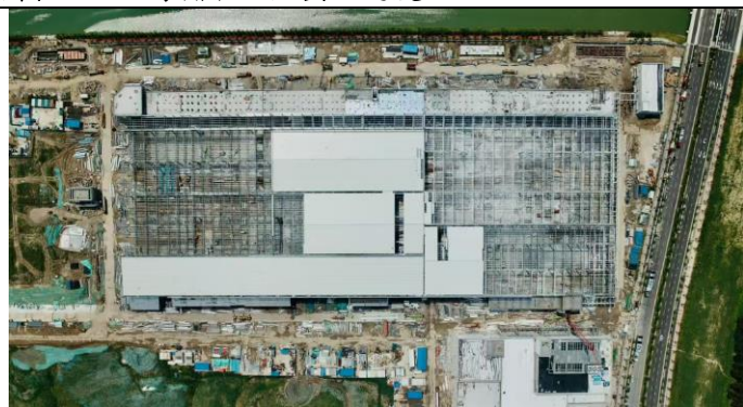
图表 97 上海储能工厂实际进度
