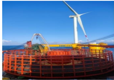
图28：公司成功将动态海缆应用于深远海漂浮式风电机组“扶摇号”
