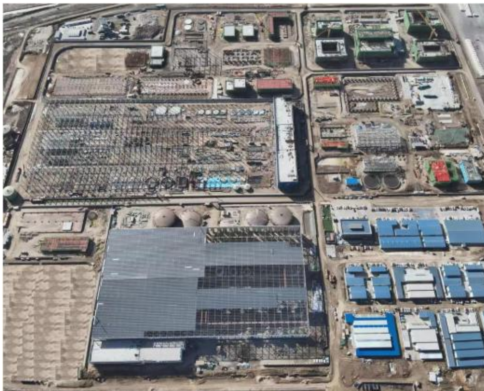
图7：公司 4 万吨/年基础锂盐一体化项目建设俯瞰图
