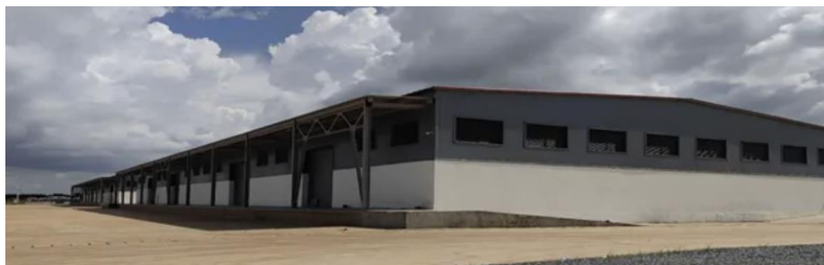
图80：卡萨项目口岸进出口保税仓及监管场地
