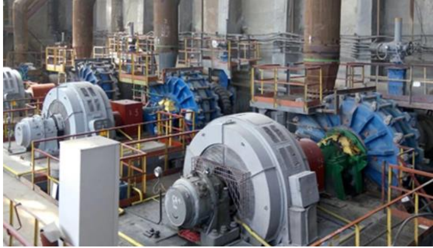
图表 1: 渣浆泵在现场的工作情况（蓝色为渣浆泵）
