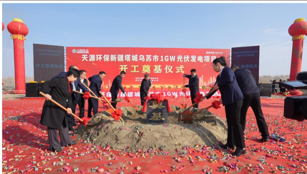
图 32：公司光伏项目开工图
