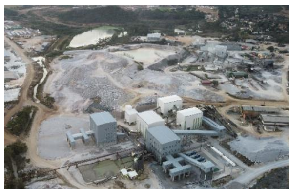
图表10: Bikita 矿山 200 万吨/年（透锂长石）重选厂
