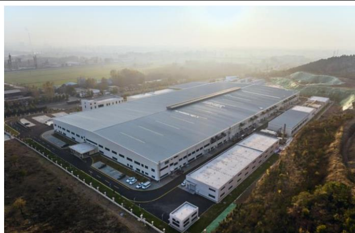
图46：奥瑞金枣庄新能源电池结构件生产基地
