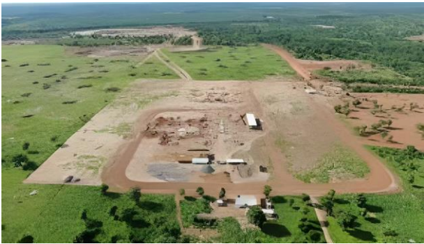
图 37 布谷尼锂矿采矿及选矿建设现场图
