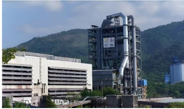
图 16 海南矿业悬浮磁化焙烧项目图
