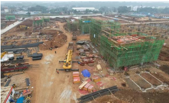
图 35 海南矿业氢氧化锂项目现场建设图
