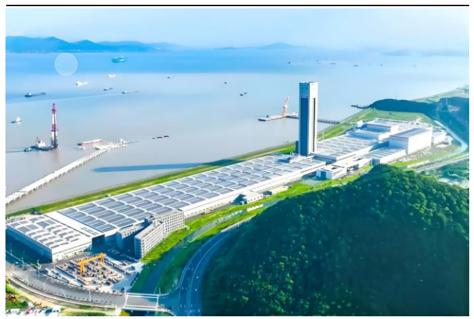
图26：东方电缆北仑基地 VCV 立塔及港口情况
