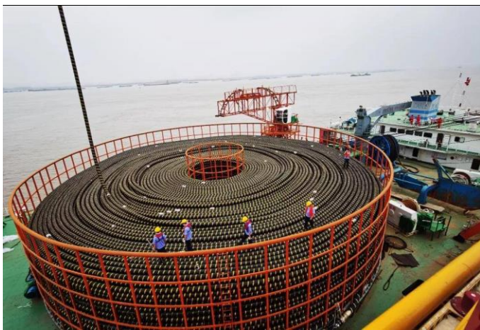
图25：海缆敷设船在港口接缆
