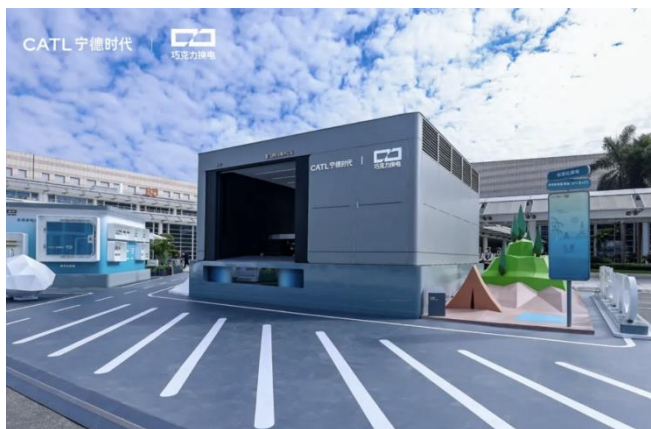
图3：换电站技术优势明显
