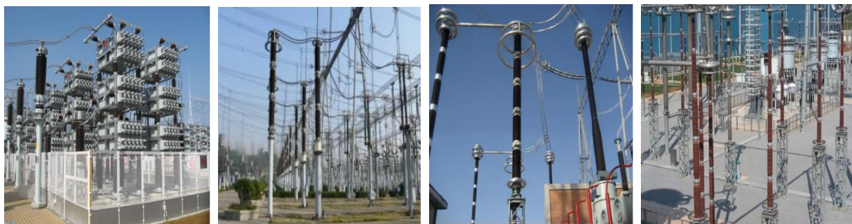
图表14：电容器、互感器、避雷器、绝缘子及套管产品示意图（从左到右）
