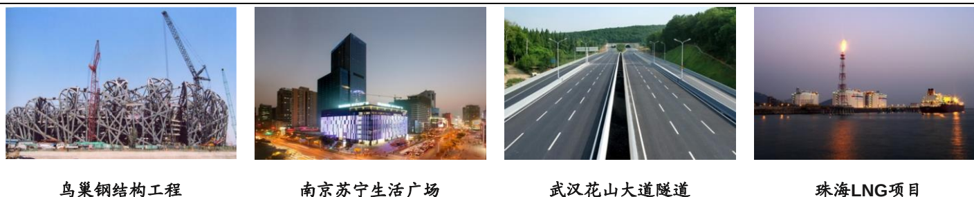
图 35：工业与民用工程板块业务范围涵盖多个领域
