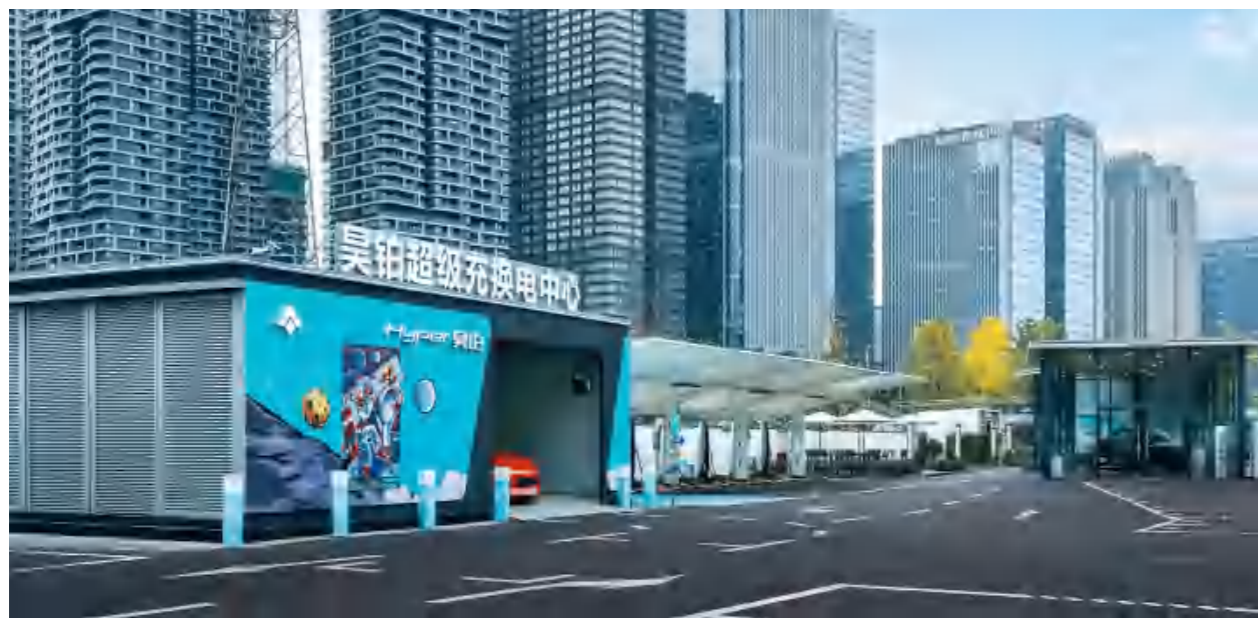
昊铂超级充换电中心
