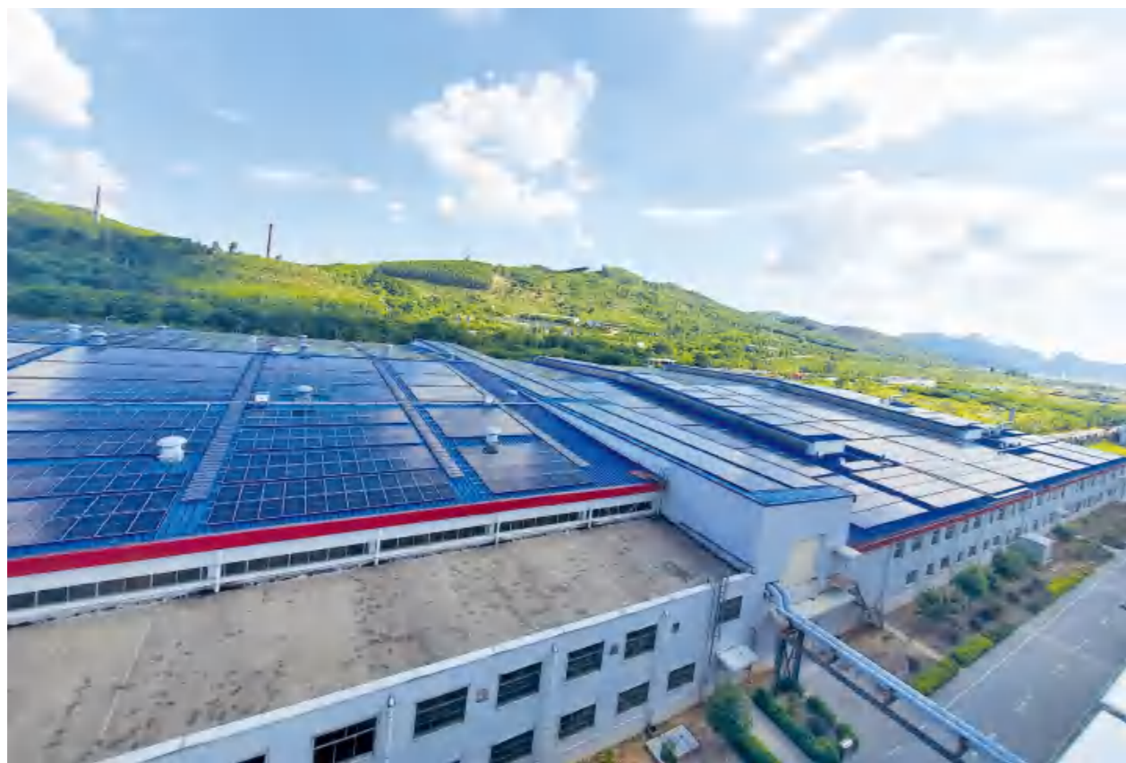
屋顶光伏新能源发电项目
