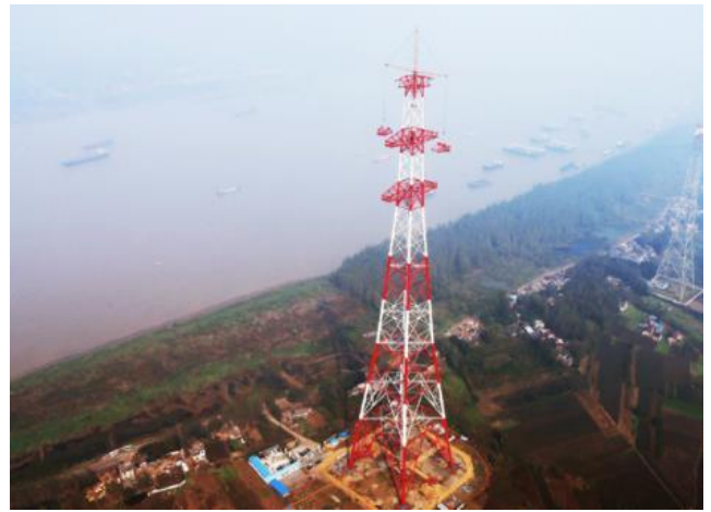
图15: 1000 千伏淮上线长江大跨越钢管塔
