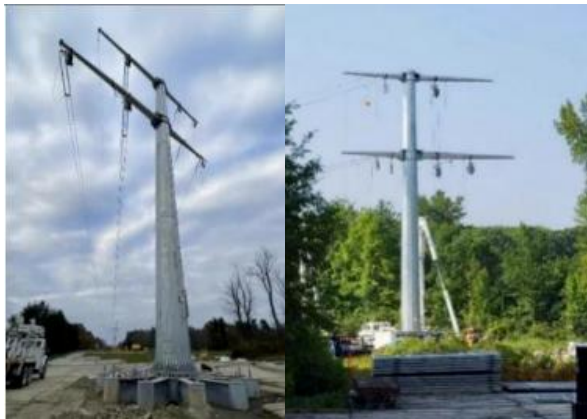
图25：美国纽约能源解决工程 345kV 钢管杆项目
