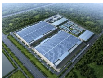
中威新能源光伏单晶硅片智能工厂
