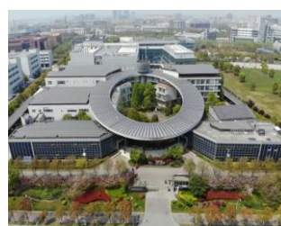
上海太阳能工程中心光伏建筑一体化
