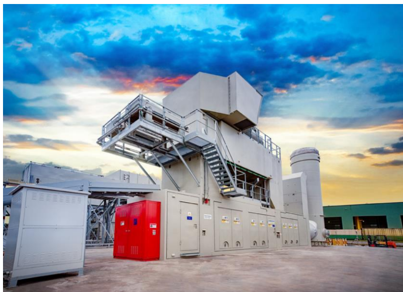
图：索拉在爱尔兰数据中心装机的燃气轮机发电机组 图：燃气轮机成为当前配套算力中心的最优供电方案
