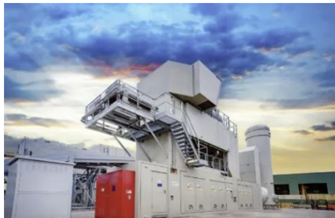
图：燃气轮机构成联合循环发电机组为爱尔兰数据中心供电，总装机量124MW
