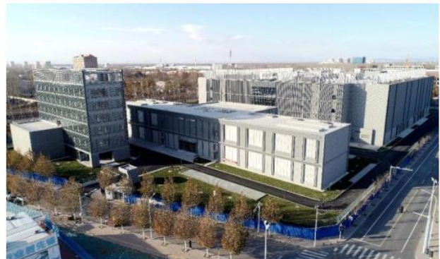
公司天津宝坻数据中心
