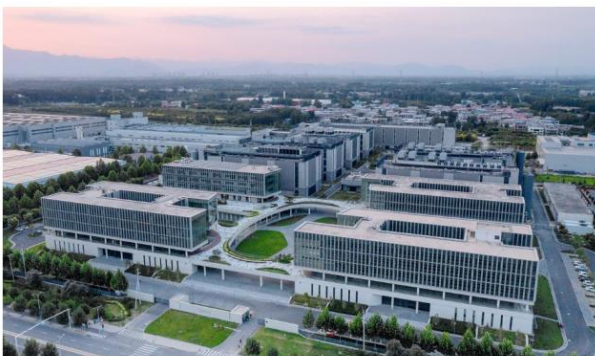
公司北京房山数据中心
