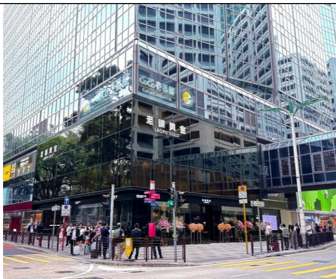
图36：老铺黄金香港旗舰店位于新港中心有幕墙露出
