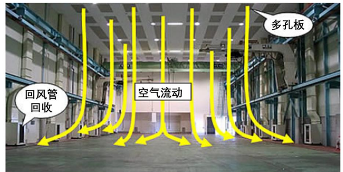
图表116: 三井精机工厂采用特殊设计的空调系统以降低温度变化
