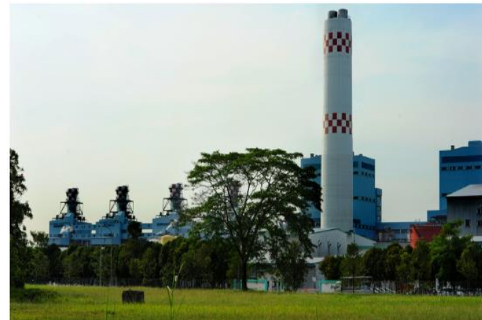
图：大士能源公用事业公司负责开发建设新加坡裕廊岛登布苏多联产项目
