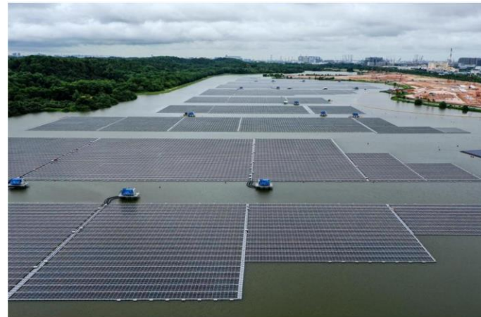
图：中国能源建设集团山西公司承建登加蓄水池水上光伏项目
