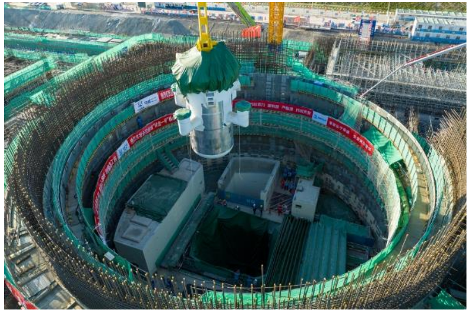
图表53: “玲龙一号”反应堆核心模块吊装
