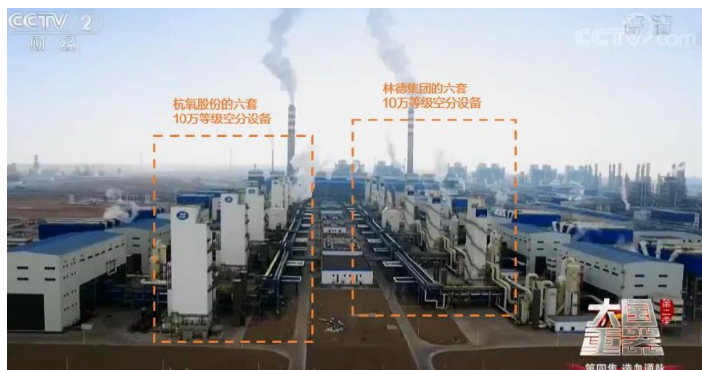
图：神华宁煤项目中杭氧和林德的空分设备
